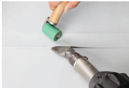
La zone de recouvrement plastifiée est assemblée par pression à l'aide d'une roulette métallique ou silicone conduite parallèlement au bec de la machine à souder. Grâce au soudage en marche arrière, la buse souffle toujours contre les zones de soudure déjà fermées.
